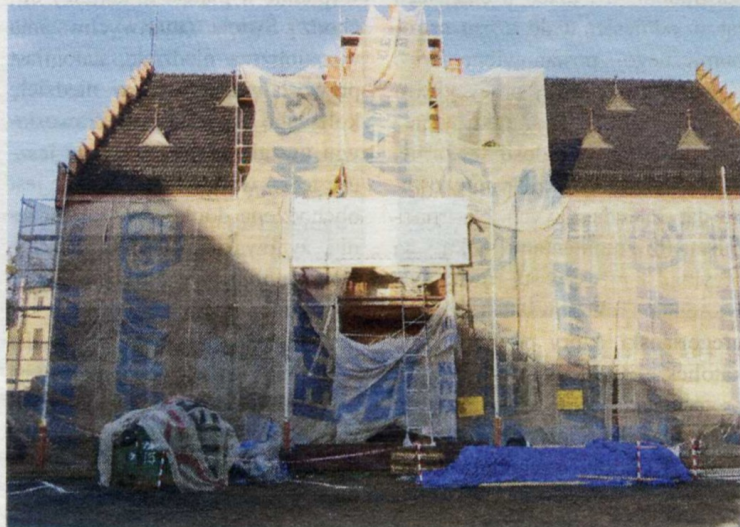
Ratusz w odolanowskim Rynku w czasie remontu i przebudowy.
