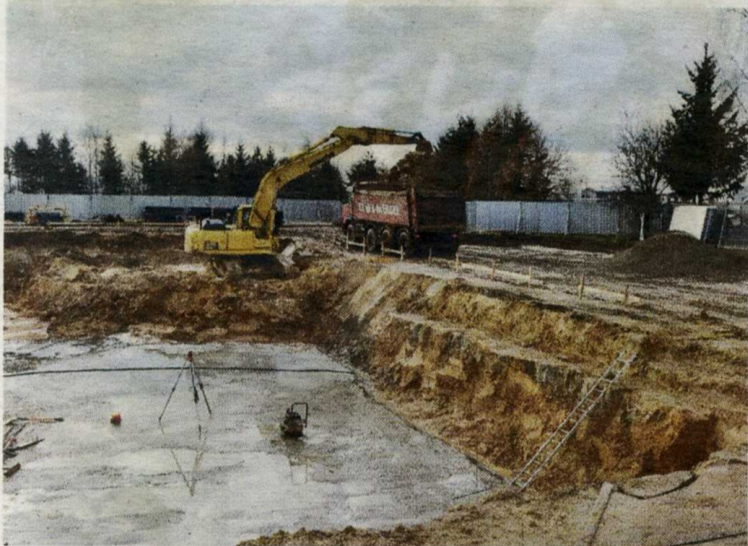
Tak wyglądał początek budowy pierwszej przyszkolnej krytej pływalni w Odolanowie. Ludzie i maszyny z miejscowej firmy DOMBUD, od razu wzięli się do solidnej roboty.
