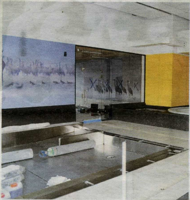
Budowa basenu znalazła się na finiszu...
